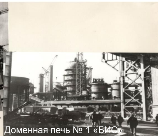
Строительство доменной печи №1 "БИС" объемом 2000 м³ 1970 г.
